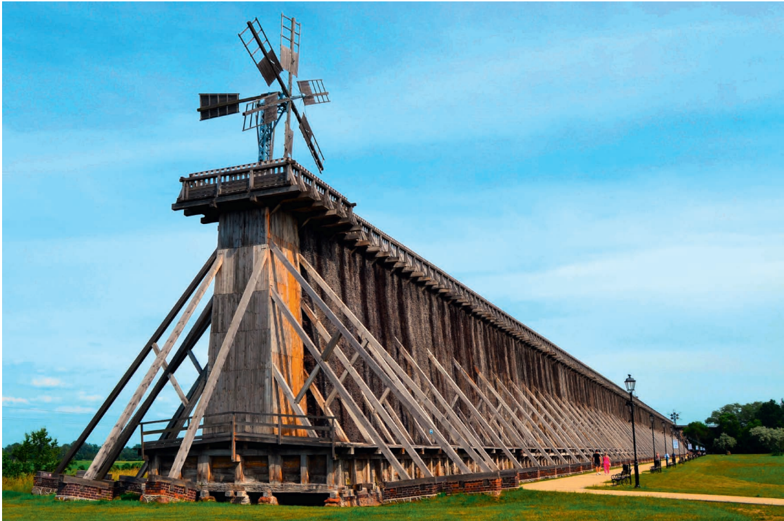
Abb. 7: Eine Wand des dreiseitigen Gradierwerkes in Ciechocinek mit Windrad. Foto: Józef Tomasz Juros.
